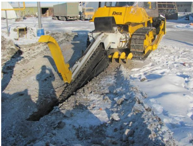
Рисунок 1 – Разрушение мерзлых грунтов
