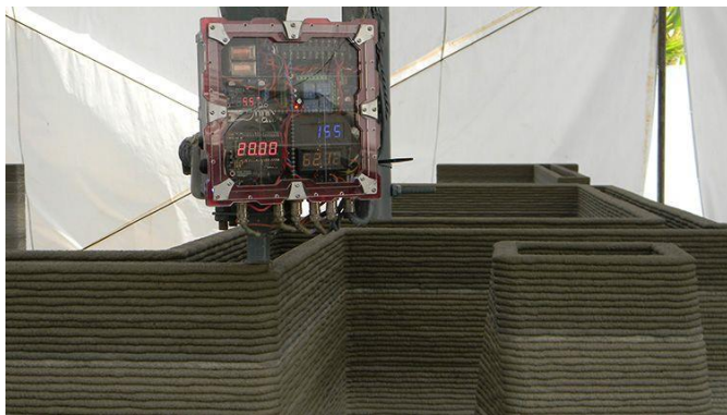
Рисунок 1 – Строительный трехмерный принтер – современная технология возведения зданий.
