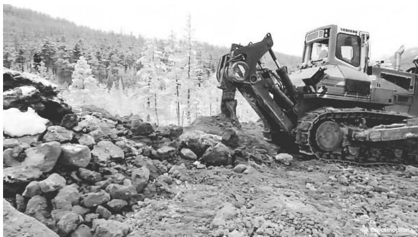
Рисунок 2 – Рыхление мерзлого грунта навесным рыхлителем
