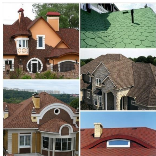
Рисунок 1 – Фото крыш, укрытых мягкой кровлей
