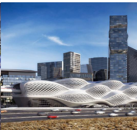
Рисунок 6 – Станция метро, Эр-Рияд, Саудовская Аравия
