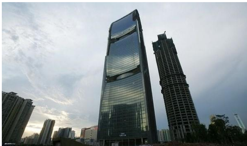
Рисунок 4 – Здание Pearl River Tower в Гуанчжоу
