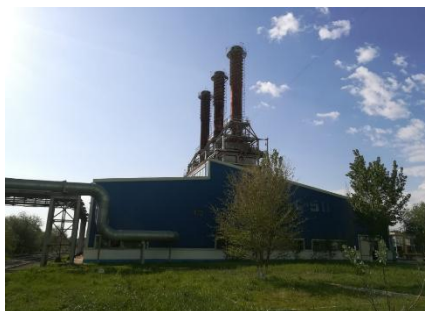
Рисунок – 5 Общий вид ТЭС КТЭЦ
