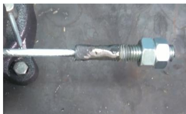
Рисунок 6 – Соединение шпильки и рабочей арматуры.
