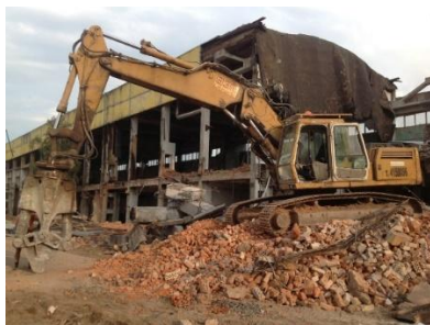
Рисунок 2 – Демонтаж здания завода г. Казань
