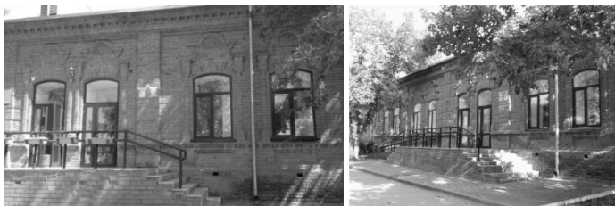
Рисунок 6 – Главный фасад и фрагмент
