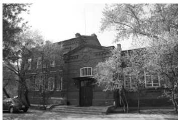
Рисунок 2 – Главный фасад здания фото 2015 год
