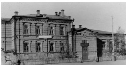
Рисунок 1 – Главный фасад здания
