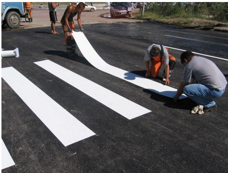
Рисунок 1 – Укладка полимерных лент
