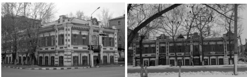
Рисунок 3 – Главный и боковой фасады, фото 2016г.
