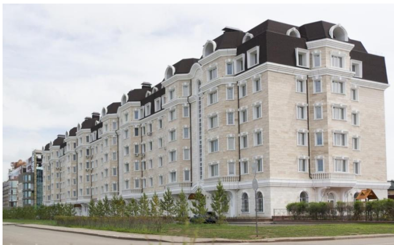
Рисунок 4 – Жилой комплекс «G-House»
